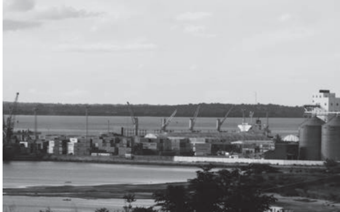
モザンビーク東岸、インド洋に面するナカラ港。「ナカラ回廊開発計画」において、内地で生産される輸出品を国外に輸出するための拠点と位置づけられている。
