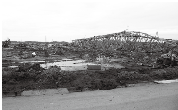
震災直後、津波で倒壊した送電線鉄塔(南相馬市沿岸部、2012年撮影)
