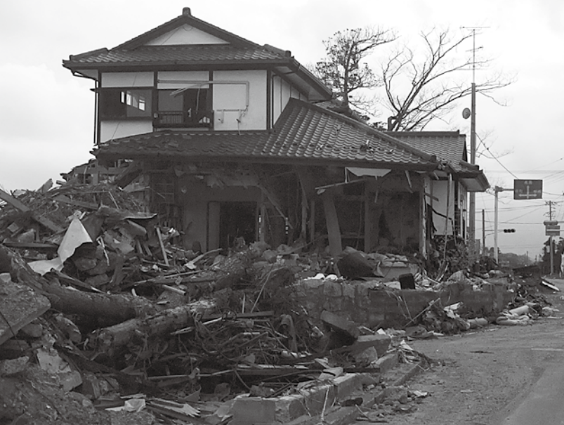
震災直後、津波で破壊された家屋 (南相馬市内、2012年撮影)
