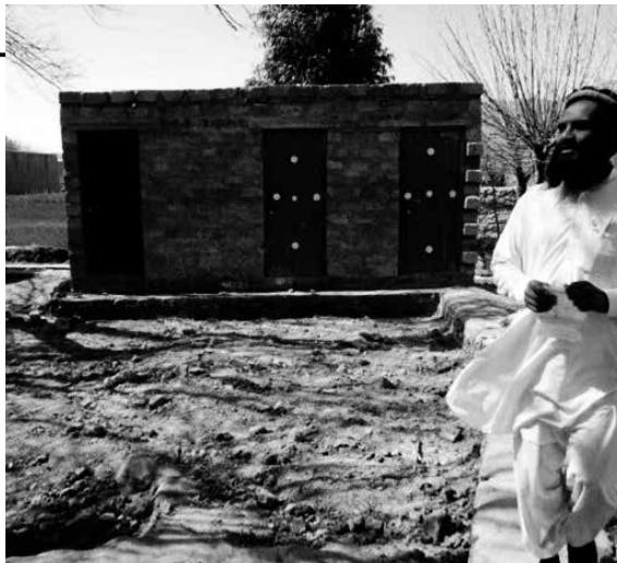
完成したバンガオ村の公衆トイレ
