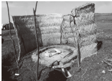
丸型の床板をはめ込んで完成したトイレ。まわりに草ぶきのフェンスを作成している
