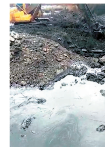
パイプラインから漏れ出た原油が地中へも浸透(MHA提供)
