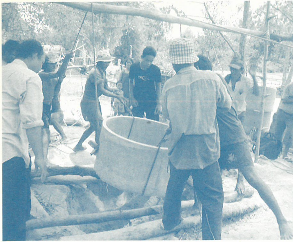
SARD：壊れたままの手押しポンプ井戸を村人たちが協力して折衷井戸に作りかえる
