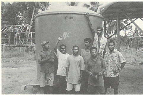
被災者の村にタンクと雨水受けを設置
