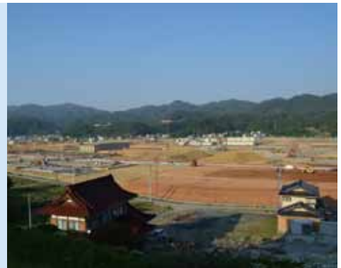
土地のかさ上げ工事が進む気仙沼市鹿折地区市街地
