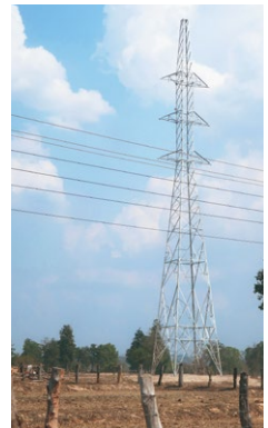
活動村に設置された水力発電ダムの送電線
