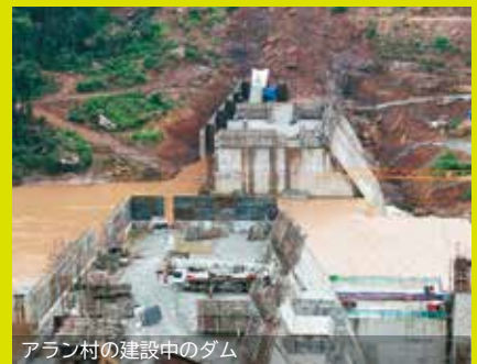
アラン村の建設中のダム
