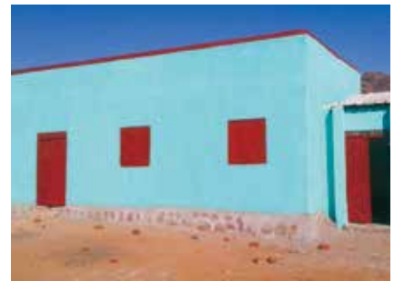
修繕され再び使えるようになった女子小学校の校舎
