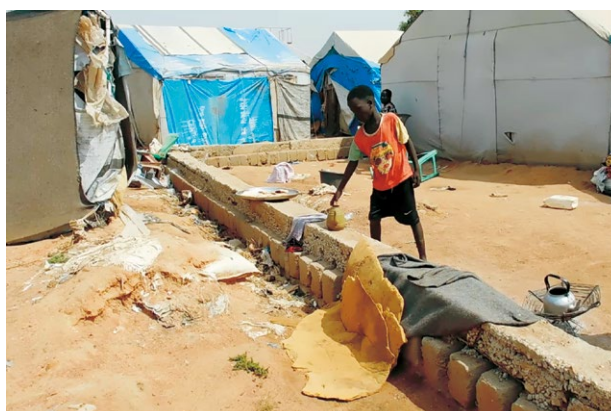
首都のジュバでは急速な開発が進んでおり、地主が住民を追い出すためのブロック塀の設置が避難民キャンプの中でさえも進められていた（南スーダン）
