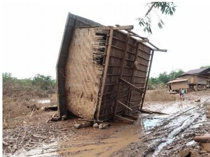
⑫倒壊した家屋（パシア村）
