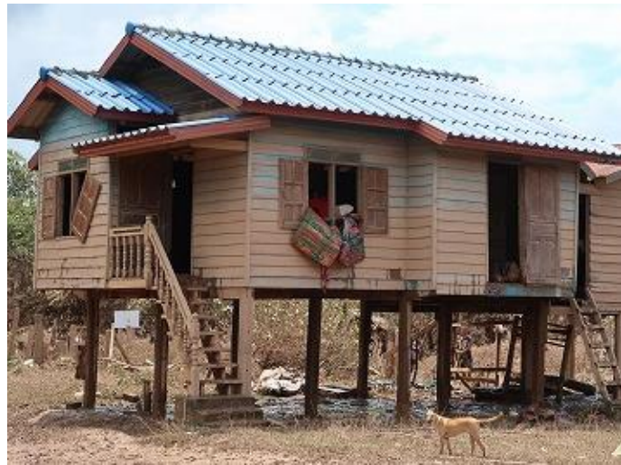
⑩床上浸水した高床式住宅（パシア村）
