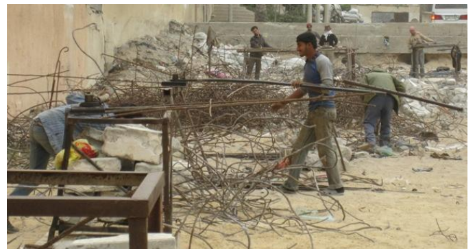
瓦礫の鉄筋を真っ直ぐに伸ばして再利用するガザの人々
