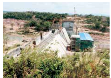
活動村近郊で建設が進むセーラノン第1ダム (2019年4月)
