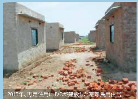
2015年、再定住用にJVCが建設した避難民居住区
