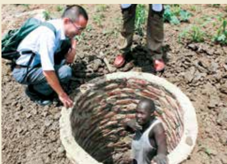
建設中のトイレ
