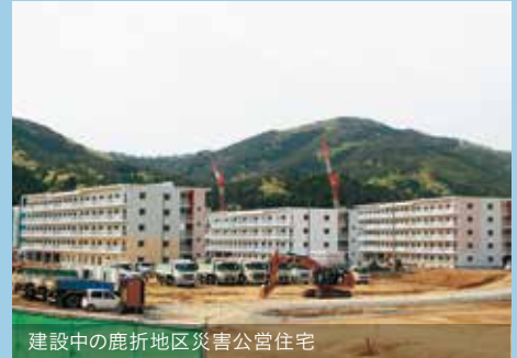
建設中の鹿折地区災害公営住宅
