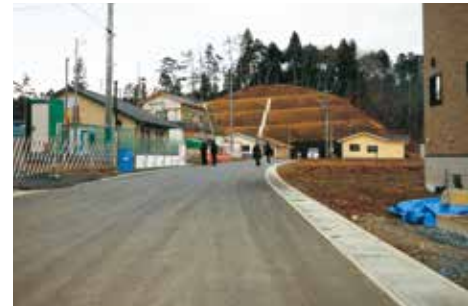
住宅建設が進む大浦地区防災集団移転造成地
