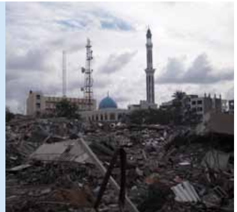
空爆で破壊されたガザ市内の建物
