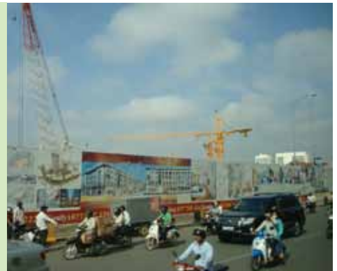
プノンペン中心部で建設中の大型商業施設
