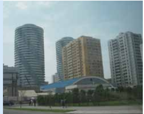
リニューアル工事のすすむ平壤市内
